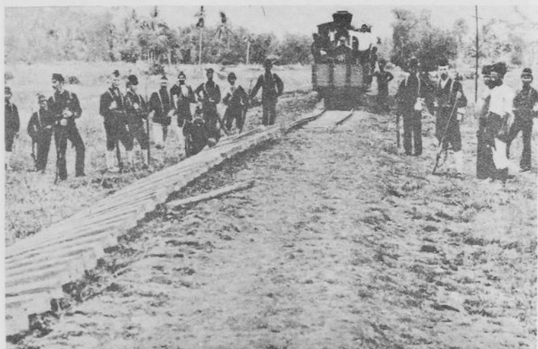
Pengrusakan jalan-jalan kereta api yang dilakukan oleh pejuang-pejuang Aceh di Aceh Utara dibawah pimpinan Pang Nanggrona, suami srikandi Cut Meutia.
